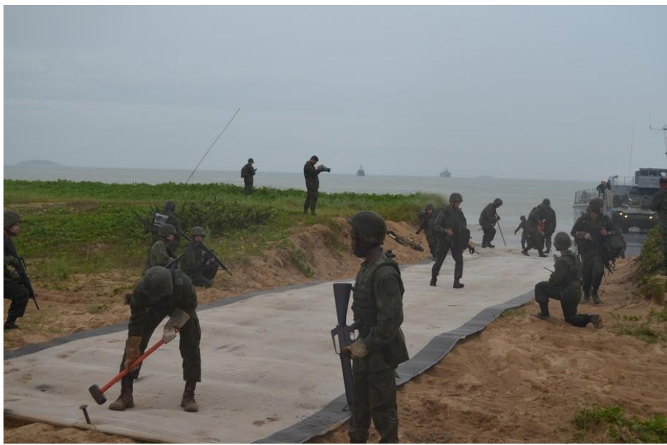
Preparação da Rampa para desembarque de viaturas sobre roda – Operação Dragão, 2016
